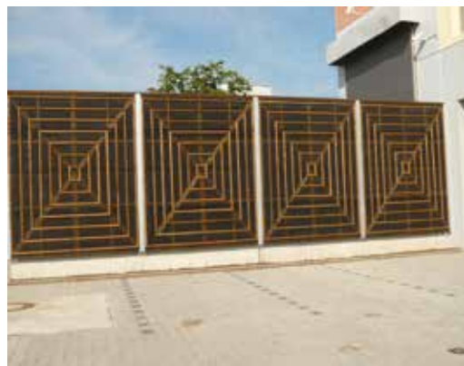
Lärmschutzwand Bad Dürkheim
