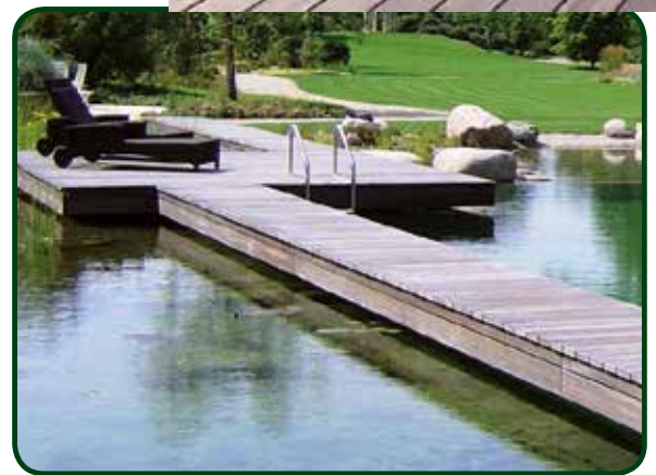
Steganlage aus Bongossi
