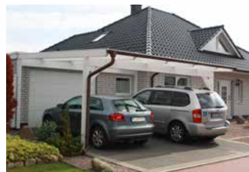
Leimholz weiß lackiert, Dach: Steg 2-fach Platten
