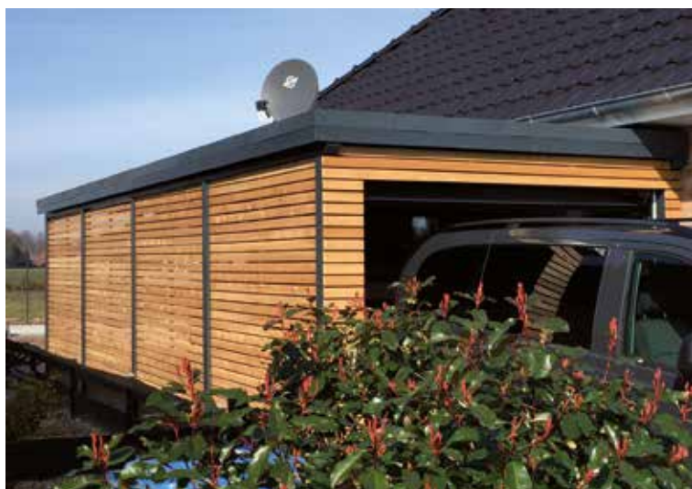
Rahmen KVH lasiert, Verkleidung Rhombusprofil, Sibir. Lärche unbehandelt, Dacheindeckg. verz. lackierte Stahlplatten, Anti-Tropfbeschichtet
