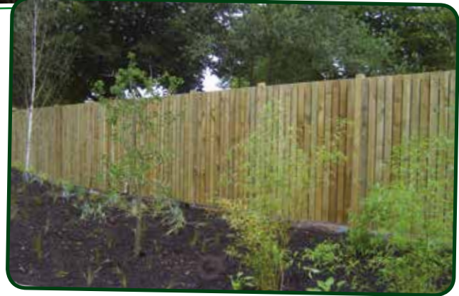
Sicht-/Lärmschutzwand aus kesseldruckimprägnierter Kiefer
