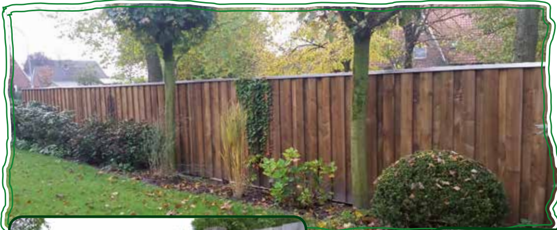
Sichtschutzzaun mit beidseitiger Deckelschalung, Lärche Kdi braun und einer Alu-Abdeckhaube
