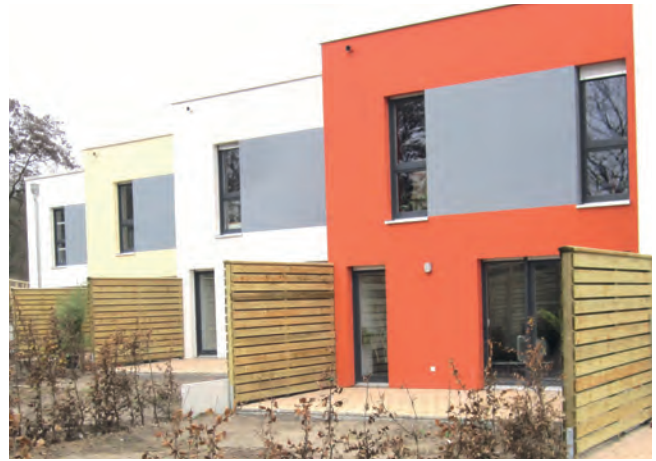
Ausstattung von Reihenhäusern in Wolfsburg mit Zäunen, Terrassentrennwänden und Müllboxen.
