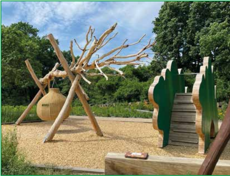
Eichenblattrutsche: Rutschpodest PH: 1.75m, Schräger Steg mit Aufstiegshilfen, Seiten als Eichenblatt verkleidet
