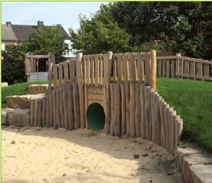
Rohreingang und Absturzsicherung
