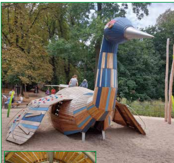
Stehender Kranich: Gesamtmaße ca. 12.50x3.00x10.00m, Sprossenaufstieg im Inneren engmaschige Dreiecknetze, 1 Fernrohr, 1 Rufsäule, 1 Tunnelrutsche PH: 3.50m
