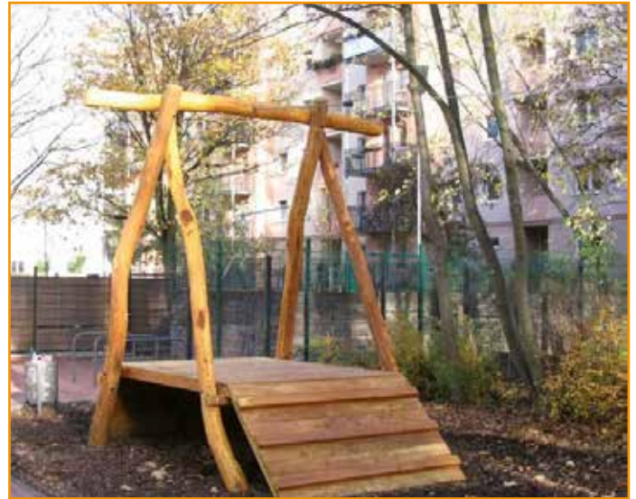
Seilbahn, Startpodest aus Robinie
